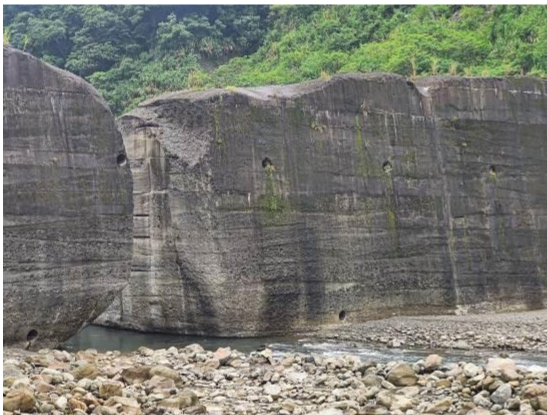
圖：被曾文溪水切穿的「福山壩」。梁廷毓提供。
